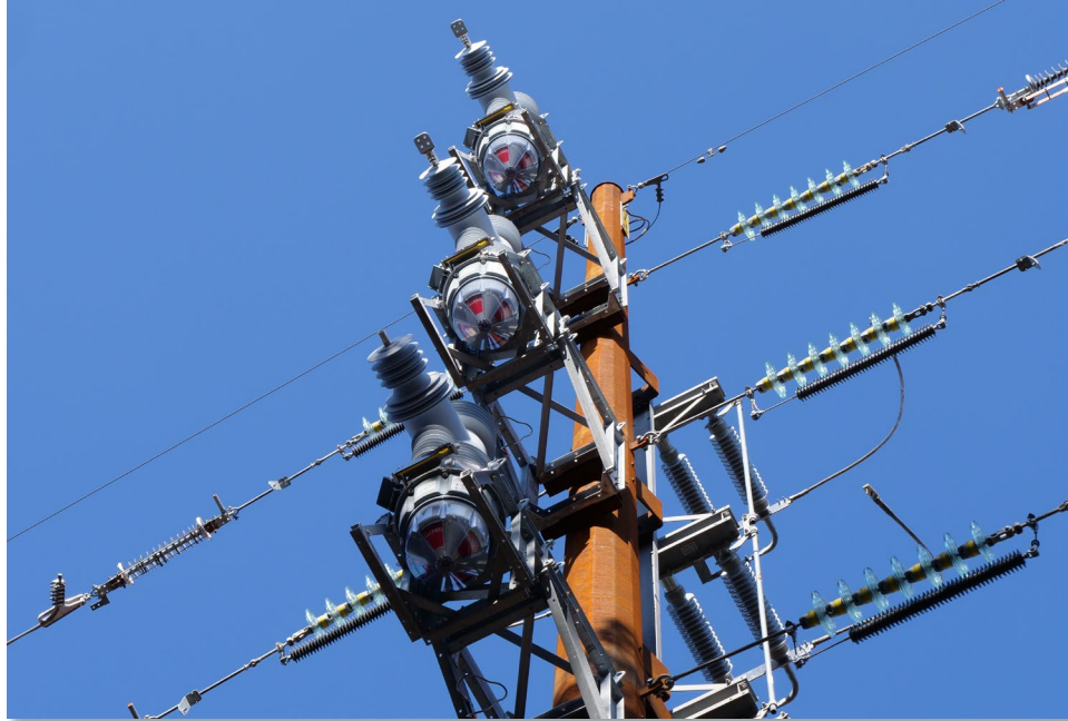
Hubbell Protecta Lite 57kV MCOV Arresters
