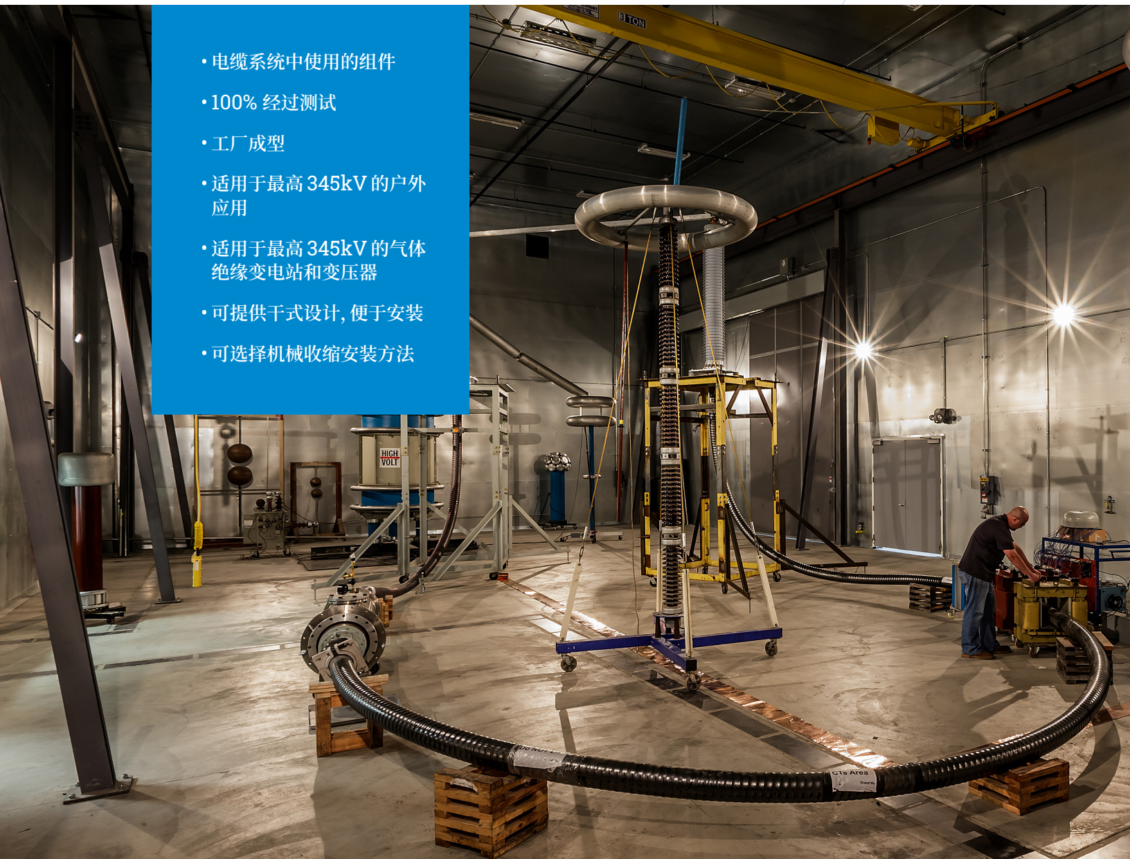
G&W Electric 位于伊利诺伊州波林布鲁克市的高压测试实验室
