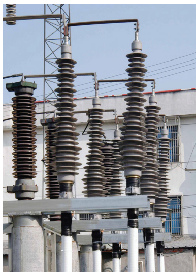
变电站应用中的干式户外终端。
