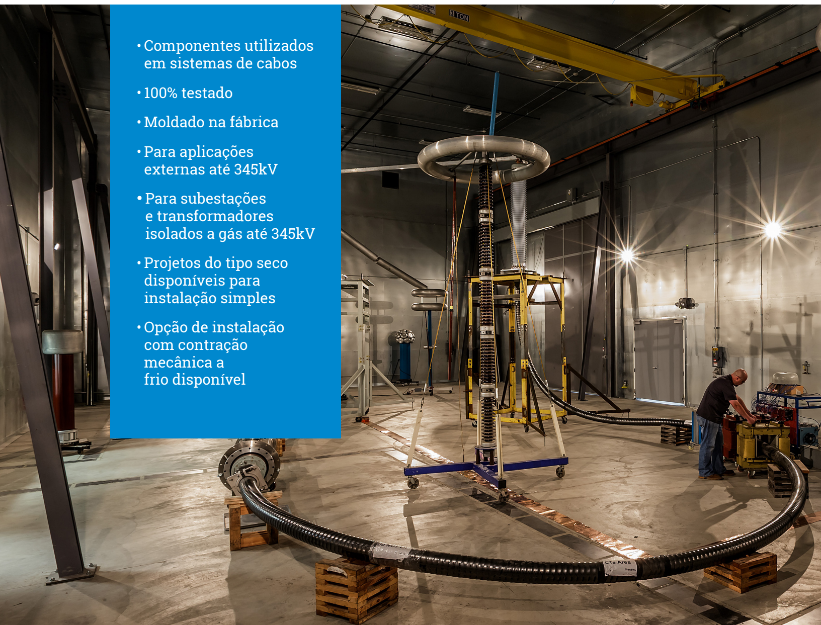
Laboratório de testes de alta tensão da G&W Electric em Bolingbrook, IL
